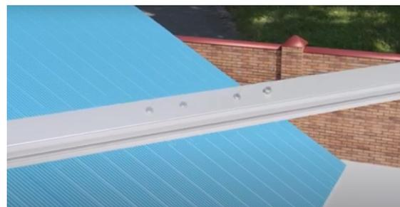
Aluminiumprofile umdrehen und den Schienenverbinder auf der gegenüberliegenden Seite ebenfalls mit 4 selbstschneidenden Schrauben sichern.
