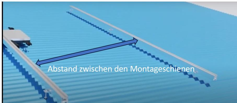
Führen Sie nun bei beiden Schienen zunächst die Mittelklemme, dann je eine Endklemme in die Aluminiumschiene ein.
