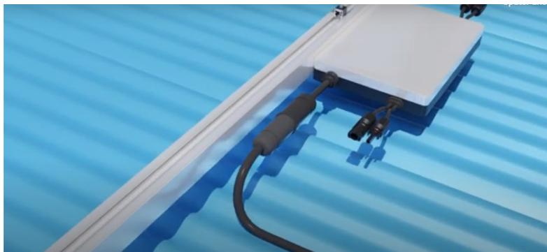
Schließen Sie nun die DC-Kabel ihrer Photovoltaik-Module an den Wechselrichter an.
