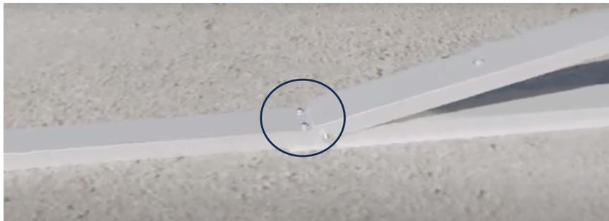
Legen Sie die 6 Ballastaufnahmen etwa mittig auf die U-Verbinder und schrauben Sie diese ebenfalls mit je 2 selbstschneidenden Schrauben ST 4,8 x 19 (12 Schrauben) an die U-Verbinder an.
