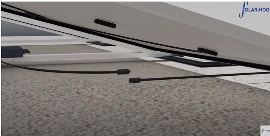
Schließen Sie nun die DC-Kabel ihrer Photovoltaik-Module an den Wechselrichter an.
