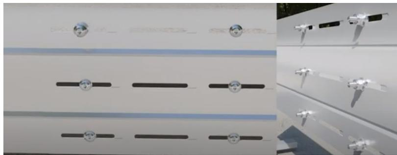
Nun werden die Windabweiser zunächst am äußeren Dreieck mit 3 selbstschneidenden Schrauben festgeschraubt. Dann am mittleren Dreieck.
